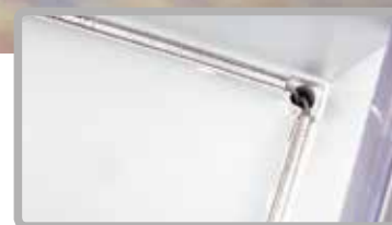
Caleira dreno da água Internal drain channel
